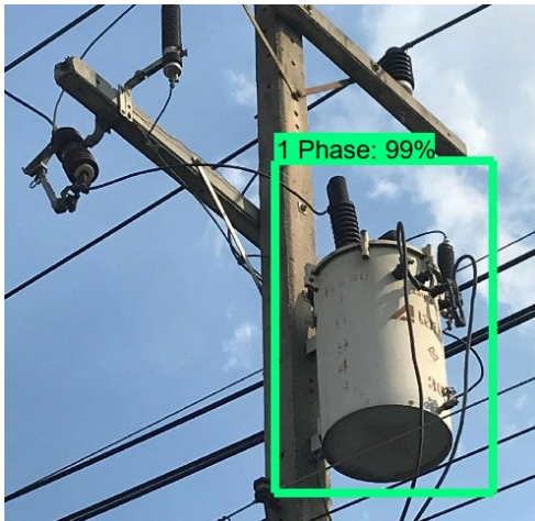
รูปที่ 4 ผลการตรวจจับหม้อแปลงแรงดันไฟฟ้า 1 เฟส
