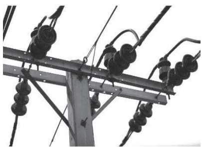
รูปที่ 1 การต่อพวงลูกถ้วยฉนวนไฟฟ้าแบบ 52-1 บนเสาไฟฟ้าระบบ 22 Kv
